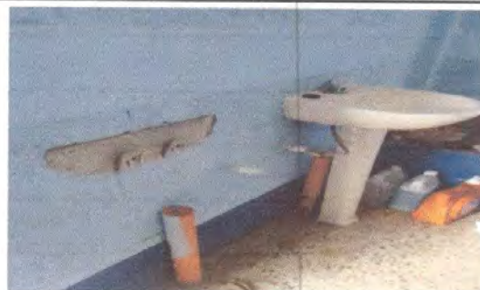
Foto 12: Sustitución de lavamanos en baño escolar
