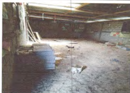
Foto 8: Reparación de piso de cemento liquido en cocina escolar
