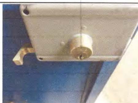
Foto 4: Sustrucción de chapas de puerta de aulas escolares
