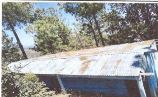
Foto 1: Sustrucción de lámina, por lámina troquelada aluzinc calibre 26 en cocina escolar
