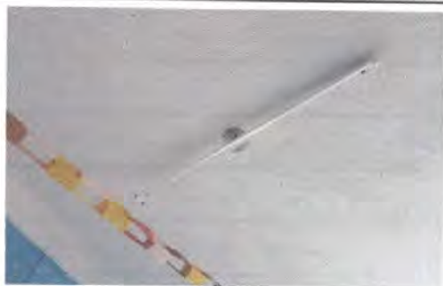
Foto 13: Sustitución de plafoneras en aulas escolares
