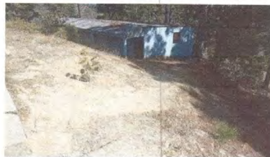
Foto 10: Reparación de piso de torta de cemento hacia cocina escolar
