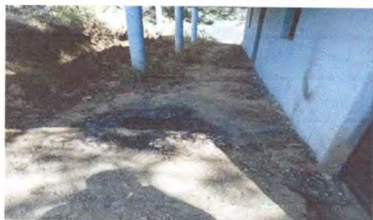
Foto 9: Reparación de piso de cemento liquido en cocina escolar
